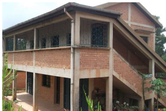
Bâtiment principal et annexe
